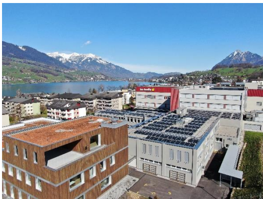
PV Anlage auf dem Gebäude der bio-familia
