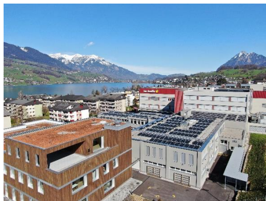
L'installation photovoltaïque du bâtiment
